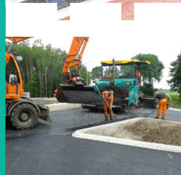
De bovenste laag asfalt, de deklaag, wordt aangebracht op de nieuwe rotonde bij de Nulweg.
