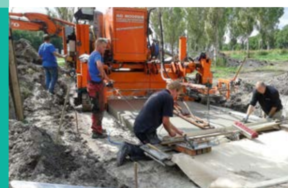
Wegwerkers brengen het nieuwe betonfietspad aan.
